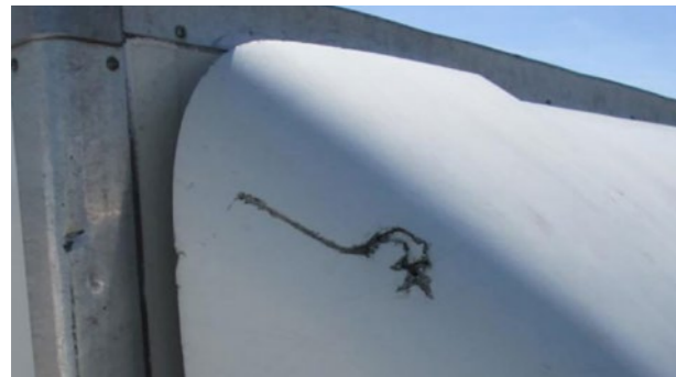
Carenatura del tetto e deflettore: riparazione economicamente conveniente
