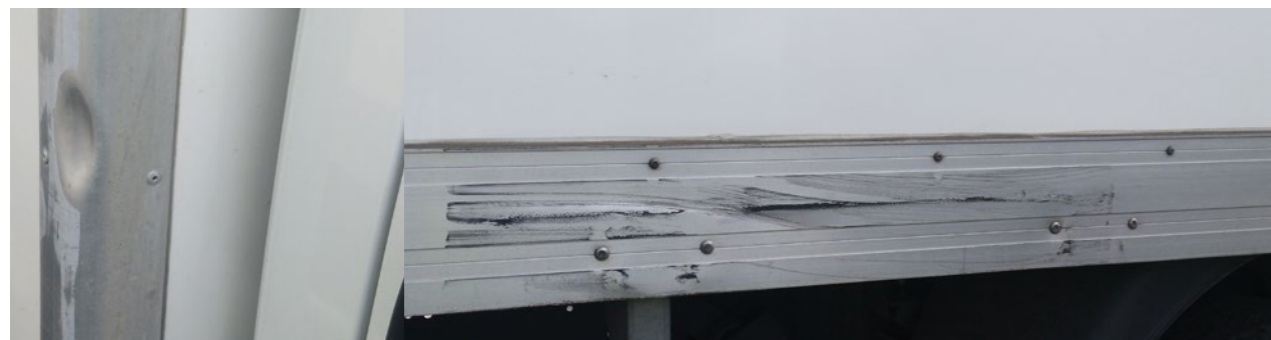
Profili laterali nel sottoscocca: deformazioni dalla riparazione economicamente conveniente
